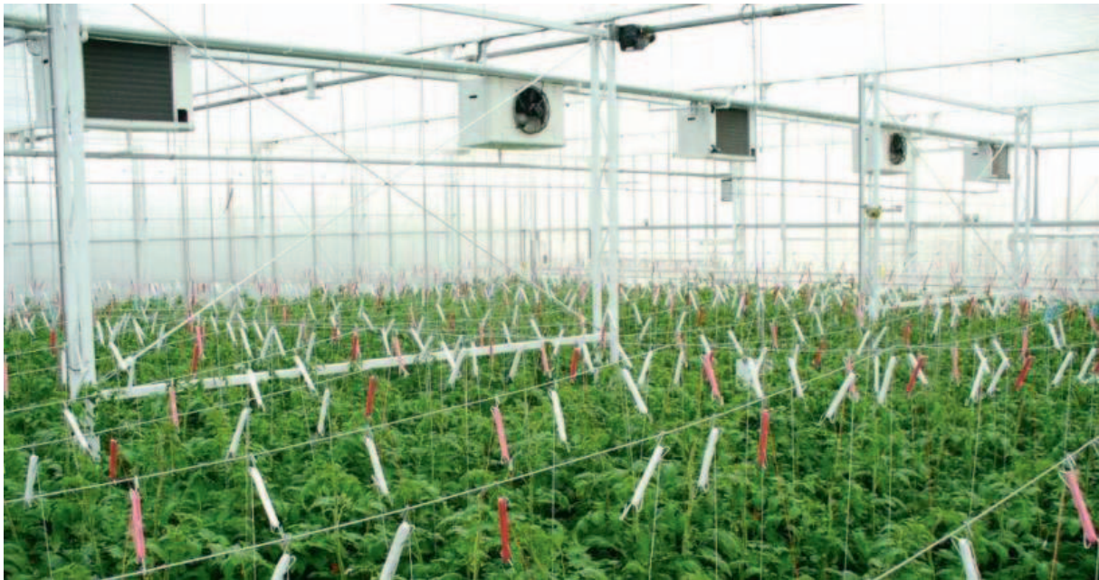
Figuur 20. Warmtewisselaars voor onttrekking overtollige warmte uit lucht boven in een semi-gesloten kas.
