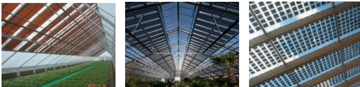
Figuur 11. Enkele technologieën waarbij de zonnecelmodules direct in het kasdek aangebracht zijn. (Foto Hermans Techniek Nederland bv, Kaatsheuvel).
